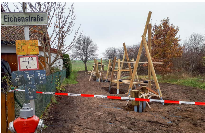
Die Struktur des neuen Spielplatzes lässt sich bereits erkennen.
