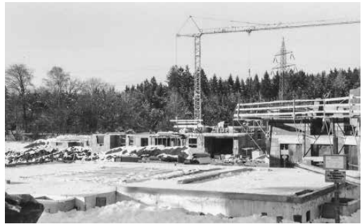
Buchenhain-West im Bauzustand
