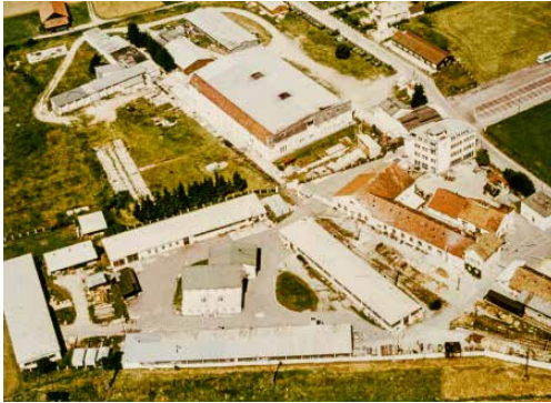
Luftaufnahme ehemaliges Küba-Gelände
