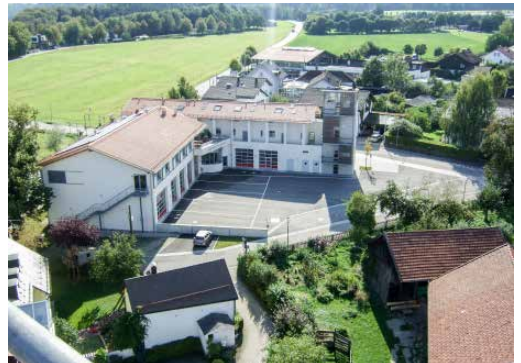
Reichenthalstraße und Feuerwehrhaus
